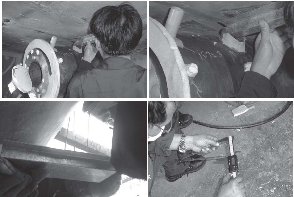
การติดตั้งกระบอกลีฟต์
