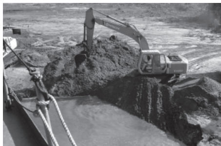
รูปที่ 35 การขุดดินรอบ ๆ บริเวณข้างเรือ กราบขวา
