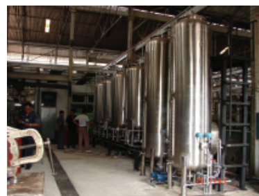
รูปที่ 22 ถังเก็บน้ำมันไบโอดีเซล ณ กรมอุทการเรือ
