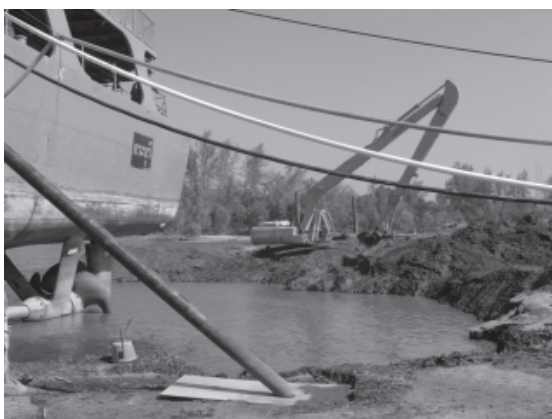
รูปที่ 33 การกู้เรือหลวงกระบะบุรี ของบริษัทอยู่กรุงเทพ (การขุดพื้นที่บริเวณท้ายเรือ)
