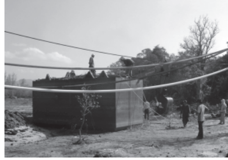
รูปที่ 34 การประกอบติดตั้งแพ (Pontoon) ข้างเรือเพื่อช่วยการลอย
