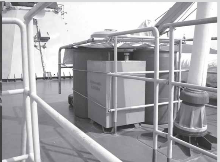
ถังเก็บน้ำมันบนดาดฟ้าเรือ ร.ล.หัวหิน
