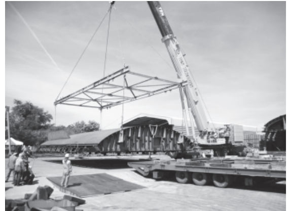
รูปที่ 6 รถครนเคลื่อนที่ขนาด 400 ตัน กำลังยกบล็อก 5 ที่มีขนาด 96 ตัน ไปวางบนรถขนต่ำ
