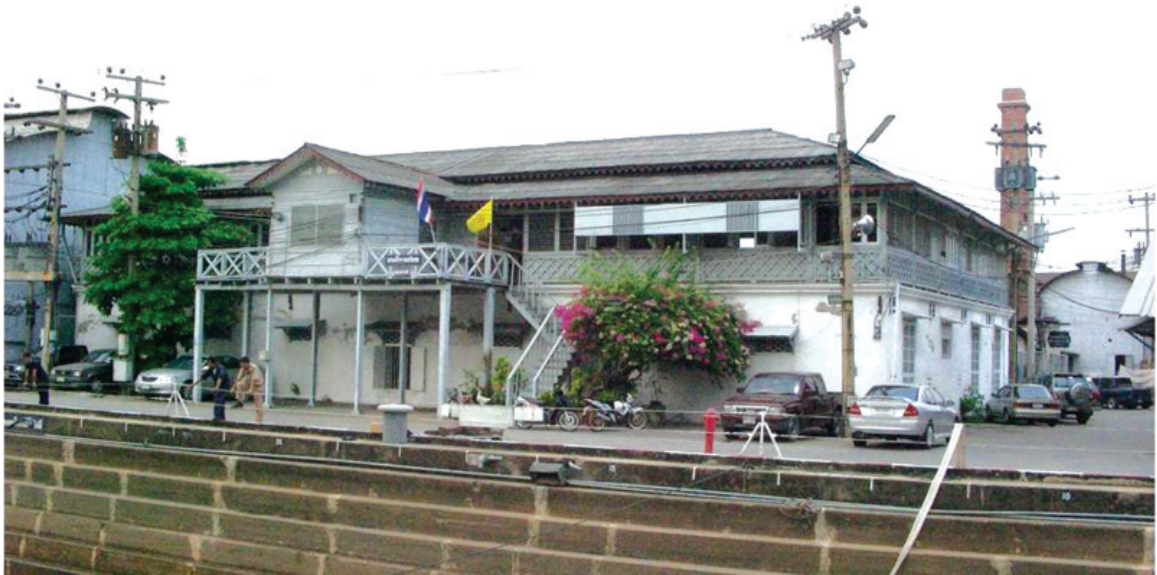
อาคารแผนกโรงงานเครื่องกล กองโรงงาน อุทการเรือธนบุรี
