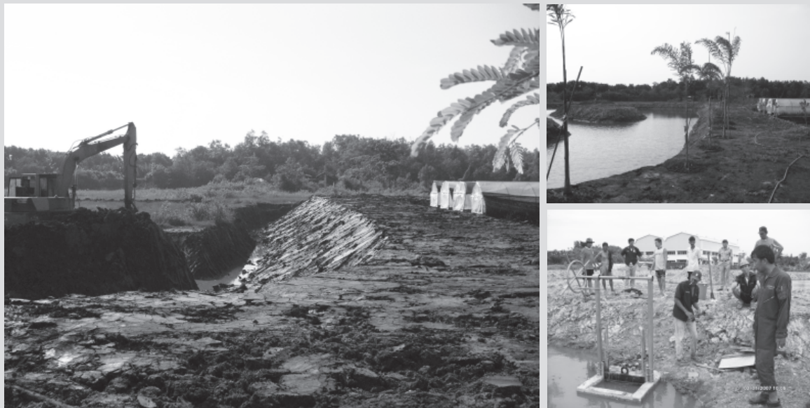
ขุดบ่อเลี้ยงปลาที่กร่อย
